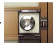
ドアを開めるとロックカバーが室内側に開いて、把手がでます。
